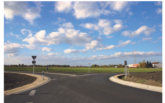
Autobahn-Auffahrt Friedberg-Bayern (Bild: Stadt Friedberg)
