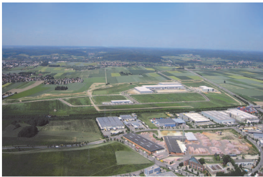
GVZ Luftaufnahme (Bild: GVZ-Entwicklungsmaßnahmen GmbH)
