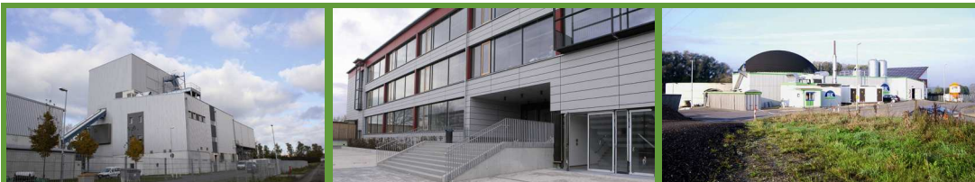
Beispiele für Klimaschutz in A 3 : das Biomasseheizkraftwerk der Stadtwerke Energie GmbH (Bild: Tom Haselmayr, Umweltamt Stadt Augsburg), das energetisch sanierte Gymnasium in Königsbrunn (siehe Texte Seite 2) und die Biogasanlage von Kühbach.
