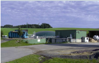
Biogasanlage im Ortsteil Tödtenried (Bild: Gemeinde Sielenbach)
