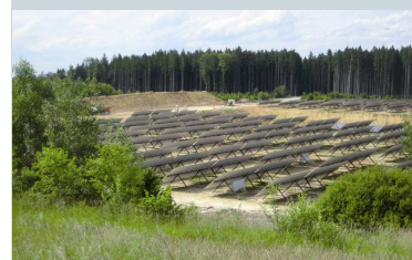
Die Flächenphotovoltaikanlage im Bereich des Lehmabbaugebietes nahe Hegnenbach (Bild: Gemeinde Altenmünster)
