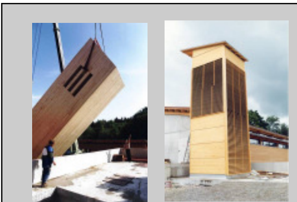
Feuerwehr – Schlauchtrockenturm, Irsee, Schwaben
