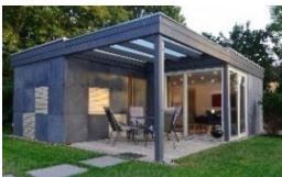
Bernhard Kölsch, betonedesign-factory Hybridmodul für Ständerbauweise mit Carbonbeton
